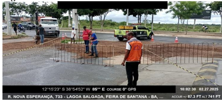
Fig.2 – Derramamento de Combustível- Fevereiro. 2025
