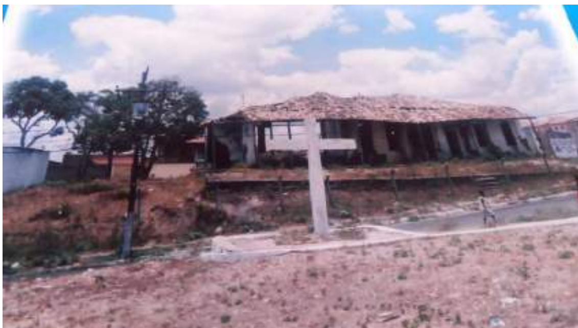
Casarão em ruínas
