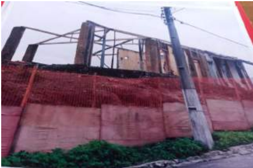
Em reforma - Foto de Manoel Machado
