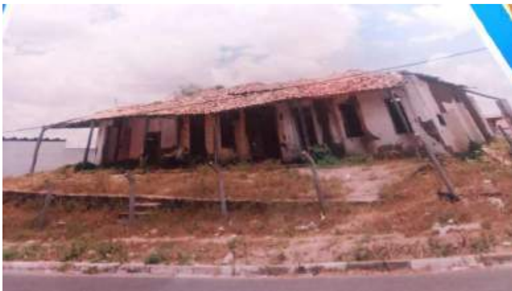
Casarão em ruínas
